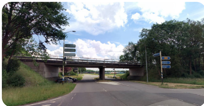
Figuur 32: Viaduct N33 over Oudeweg, punt 8 op de kaart. (Bron: Cyclomedia.nl)
